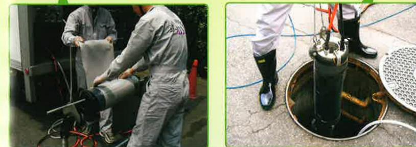
補修材の取り付け
