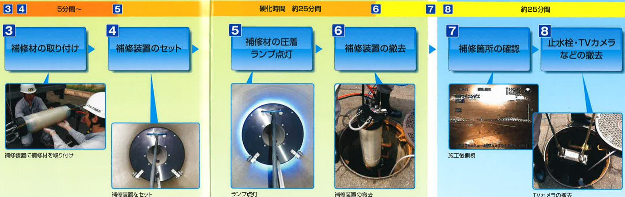
※補修材の取り付けからマンホール内へ挿入までの一連の作業は必ず遮光状態で行います。
